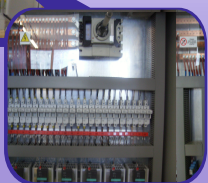
Fusibili extra-rapidi a protezione degli statici!!!
